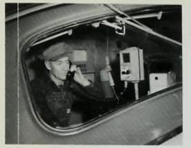
Trois systèmes de radio mobile permettent la communication train à train, train à station et locomotive à wagon de queue.
